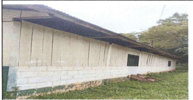
Foto 2: modulo 2 Cambiar las tabla de estas aulas se continuará con mas hiladas de block.
