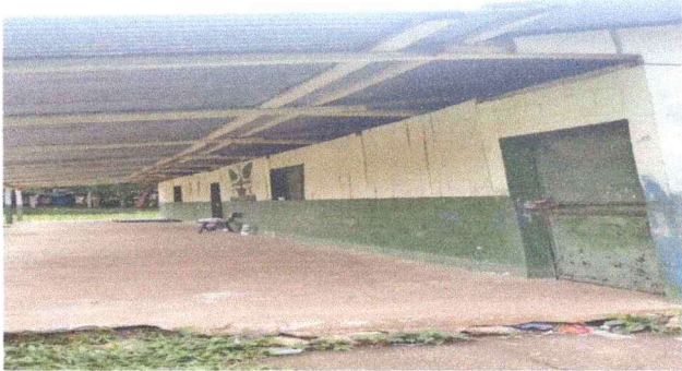
Foto 3: MODULO 2 Parte frontal se va para continuar con mas hiladas de block.
