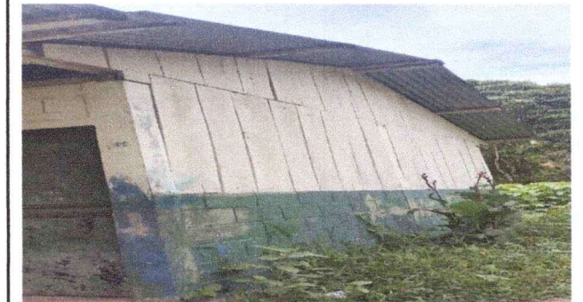
Foto 4: MODULO 2 Parte lateral sustitucion de tabla por más hiladas de block.
